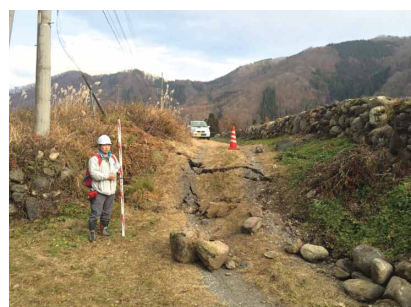
写真1 長野県北部の地震で出現した地震断層。地表の撓みとして現れた。撓んだ部分に裂け目(クラック)が生じている。脇の石垣も崩れた。今回の地震による農道の上下の食い違いは約50cmほどであるが、神城断層沿いの低崖に沿って地面が食い違ったため、崖の高さが1.5m程度にみえる。
