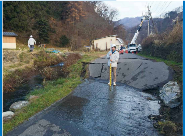
長野県北部の地震で生じた比高80cmの断層崖。地震断層はアスファルト路面と小水路、水田を北北西-南南東に横切る。6ページ。▲
