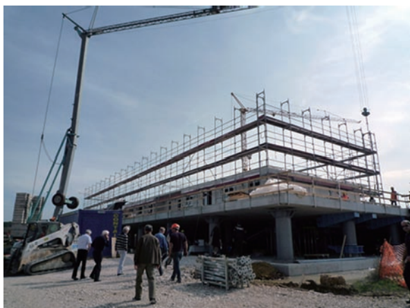
写真2 ラクイラで建設中の被災者用住宅。免震構造の人工地盤をつくり、その上に建物を建てています。このため、建物の建設に地盤の違いを考慮する必要がなくなるとのことでした。
