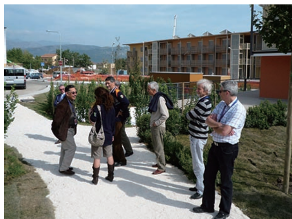
写真3 市民防災局のスタッフに案内されて、被災者用住宅の建設現場を見学する委員会メンバー。
