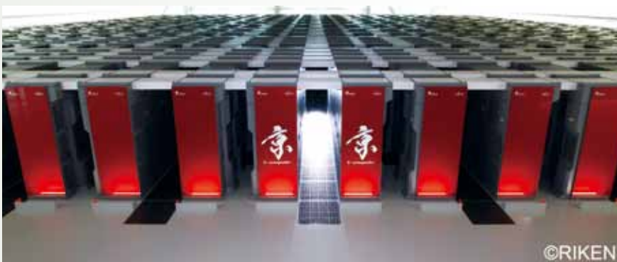
写真1 「京」コンピュータ設置風景。96個のCPUが搭載されたラックが800個以上接続されています。
