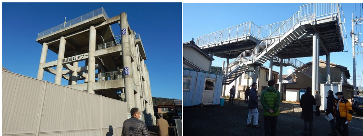
図4 想定最大級津波に対応した津波避難タワー（左）と指定が解除された旧・津波避難タワー（右：徳島県海陽町，2023年12月，久田撮影）
