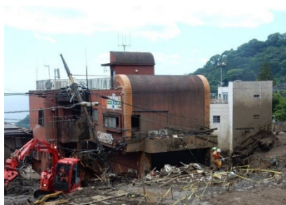
a) 残存した RC 造建物
