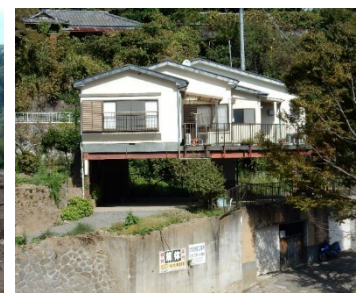
b) 残存した混構造(S+木造)
