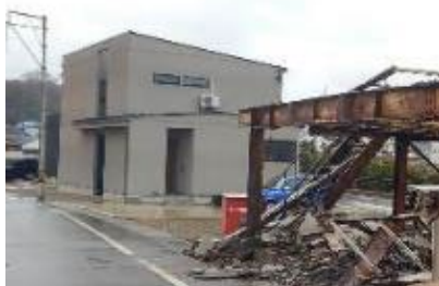
図 15 2024 年能登半島地震の大規模延焼火災に対して、2000 年基準の木造住家が延焼被害を逃れた「奇跡の家」（写真の家の背後にもう 1 棟存在）
