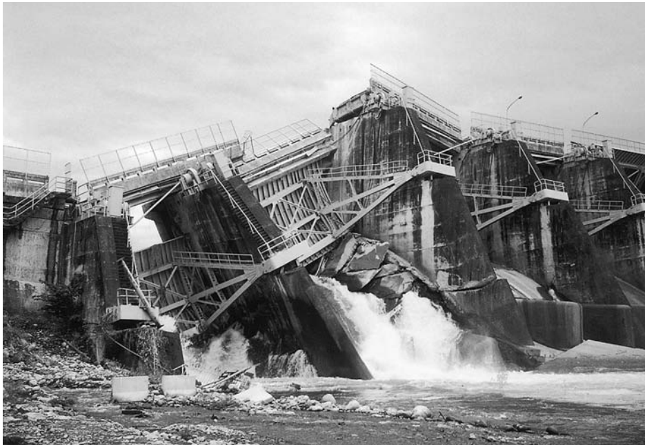
地表地震断層の北端に位置する石岡ダム被害。集集地震の発生にともなって、河床に約8mの段差が生じ、ダムは完全に決壊した。河井正氏（電力中央研究所）撮影・提供。
