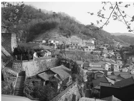
写真1 斜面住宅地の状況（呉市両城地区）
