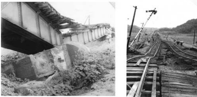
写真 1948年福井地震による鉄道の被害。(気象庁より提供)
