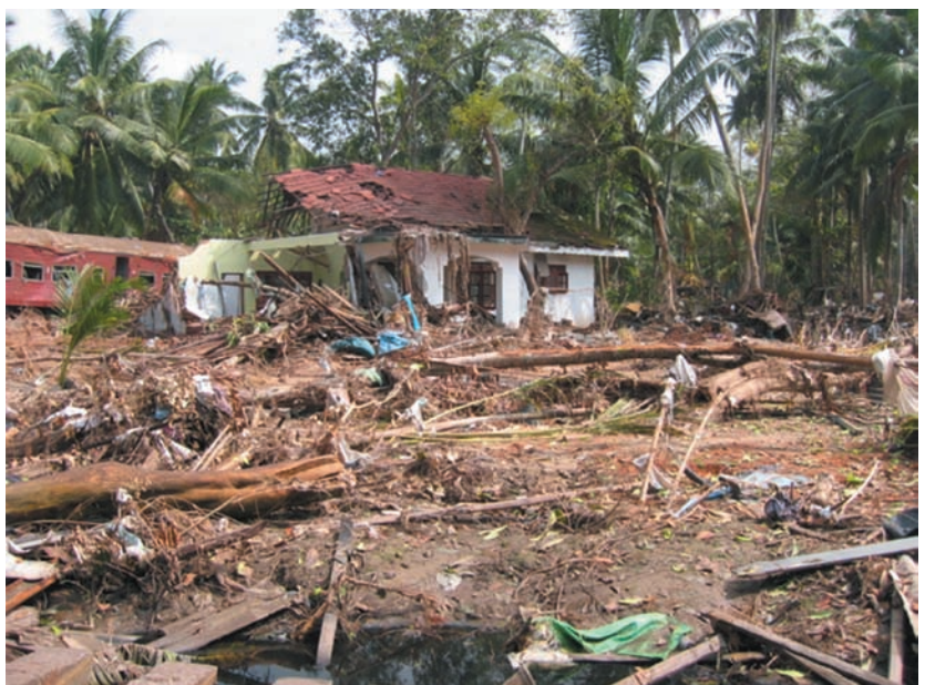
写真1 スリランカ、カハワ地区での被災状況(列車も流された)
