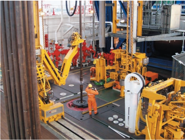
写真 ドリルフロアにおけるドリルパイプの接続作業。
