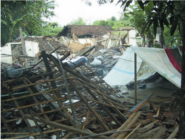
写真1 被災中心部の倒壊集落と仮設テント。
