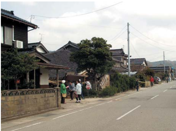
写真 能登半島地震で被害の出た輪島市門前町道下地区 [ 鹿島小堀研究室 諸井孝文氏撮影 (2007.3.28) ]
