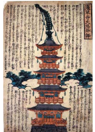
図2 五重塔九輪曲るといふ錦絵。『地震火災版画張交帖』より「浅草寺大塔解譯」(東京大学総合図書館所蔵)。
