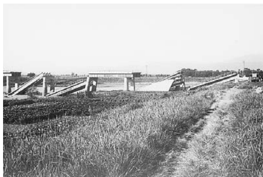
橋桁が落下した国道中角橋(九頭竜川)。小林啓美氏撮影・提供。
