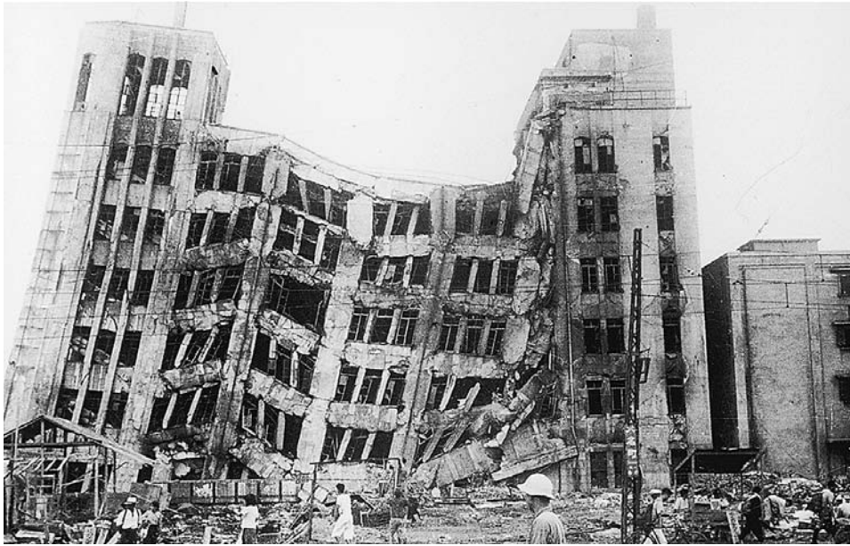
損壊した大和百貨店（福井市）。1階が潰れ、各階の梁が著しく破壊し、また火災による被害も受けた。小林啓美氏（東京工業大学名誉教授）撮影・提供。
